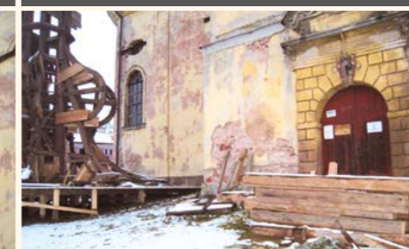
Pohled na vstupní portál kostela
