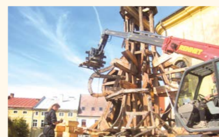
Demontáž poškozených prvků věže kostela
