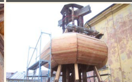
Obnova krovu věže kostela před dokončením
