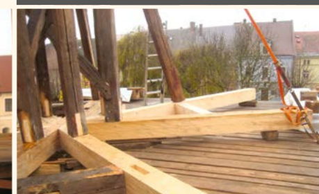
Obnova spodního kříže věže
